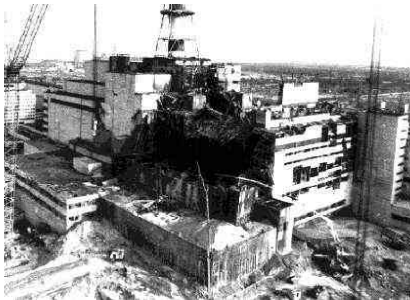
Fig. 5 – La centrale di Chernobyl dopo il disastro del 1986. (fonte: INS – International Nuclear Safety , < http://insp.pnl.org >)
